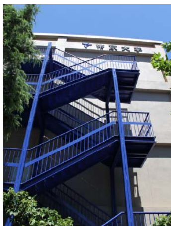
（下：空き学校舎の改修・用途転用時の景観の配慮・工夫<屋外階段のみのイメージカラー採用>） 写真 小規模な計画・補改修工事等における景観形成に資する配慮
