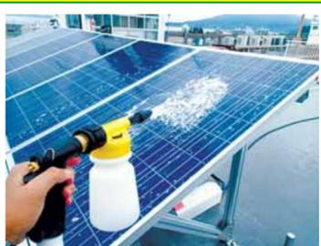
※パネル表面だけでなく、モジュール枠や金属部分を含む全ての設備をコーティング、保護
