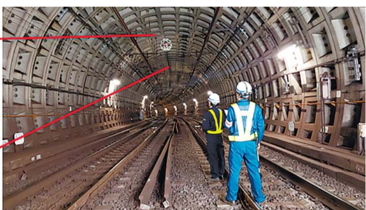
東京地下鉄が導入したトンネル点検用ドローン
