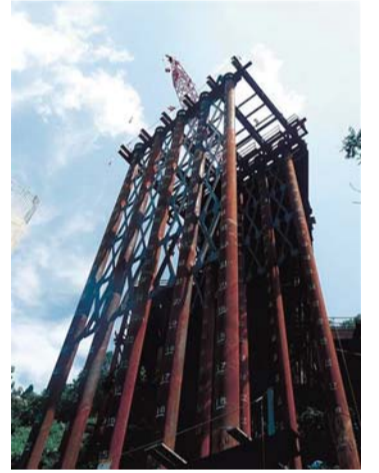
高知丸高のSqCピア工法
