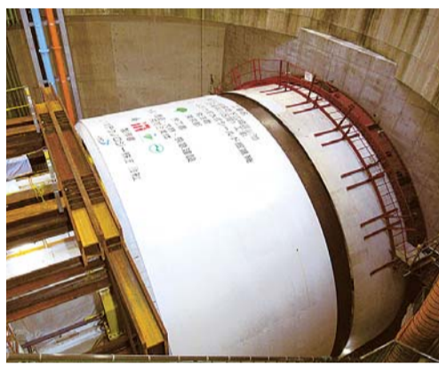
環状七号線地下広域調節池(石神井川区間)シールド機
