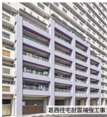
葛西住宅耐震補強工事
