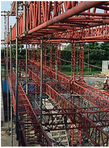
深田鉄工のパーフェクト工法
