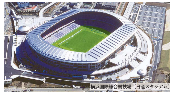
横浜国際総合競技場(日産スタジアム)
