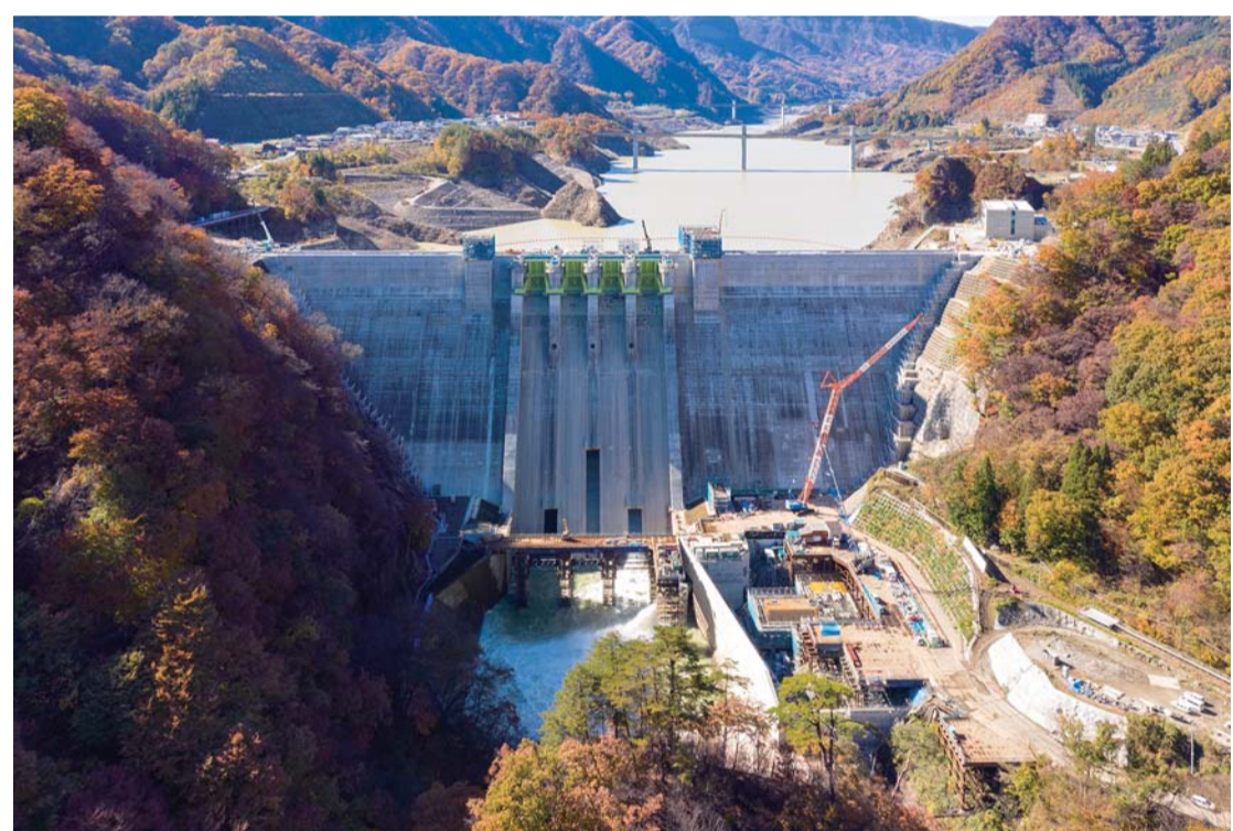
2019年台風19号では試験湛水の中にもかかわらず、約7,500立方メートルをため込み治水効果を発揮した「ハッ場ダム」(19年11月撮影、写真提供・清水建設)
