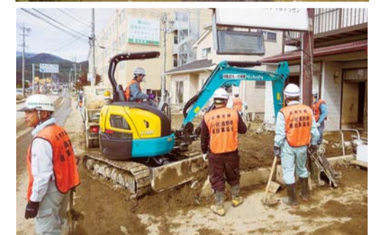
長野県建設業協会による土砂撤去道路清掃作業
