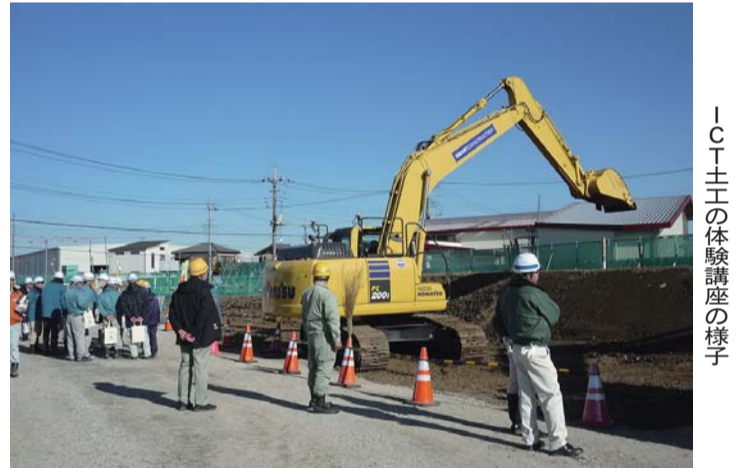
ICT施工の体験講座の様子
