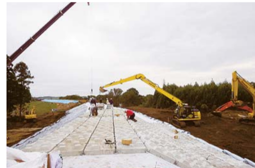
都幾川の堤防復旧(提供・埼玉建設業協会)
