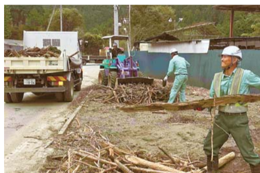
群馬県藤岡市下白野でがれき処理(群馬県建設業協会)
