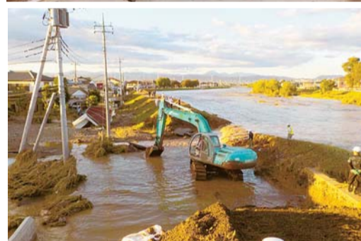
栃木県建設業協会による河川堤防緊急応急
