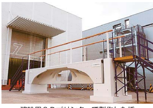
建設用3Dプリンターで製作した橋
