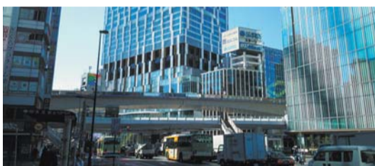
渋谷駅周辺整備事業（東口歩行者デッキ）
