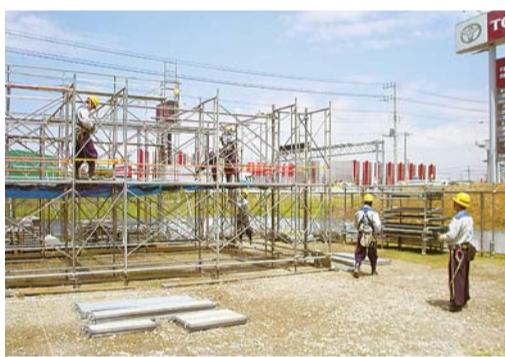
現場や枠組足場などの組み立て・解体、仮囲いの設置、外部養生などの訓練を繰り返し、基礎となる技術・技能を習得
