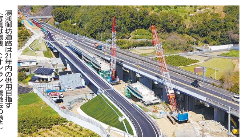
湯浅御坊道路は21年以内の供用を目指す(写真は湯浅ICオアシス橋撤去の様子)
