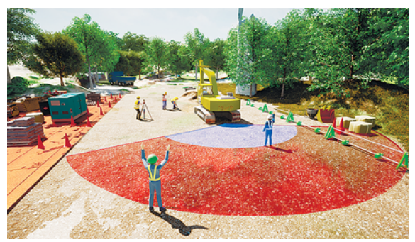
合図を送る人の姿勢を読み取るAI姿勢検知システム「Ais」
