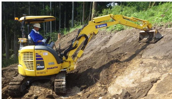
これまで幅員が狭く小型建機でないと施工が不可能であった箇所のICT施工が後付けMGにより実現。丁張レスにより狭小箇所の法面整形と構造物敷設箇所の床掘作業効率が格段に向上。
