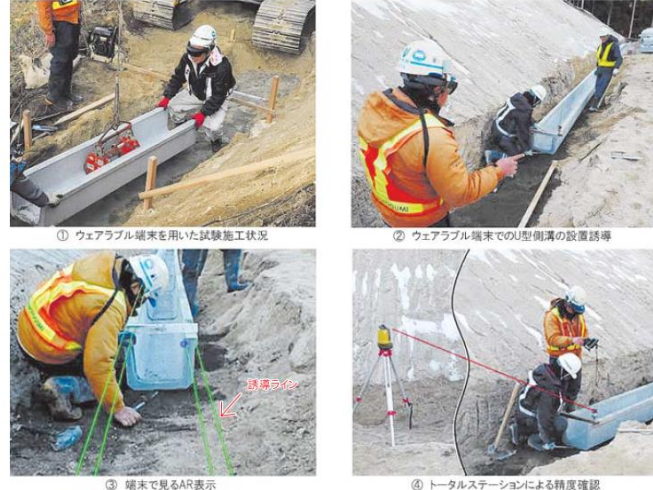
据付け作業時間を48%削減した取り組み
