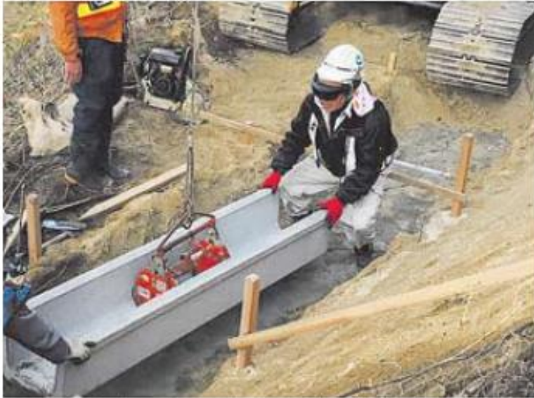
① ウェアラブル端末を用いた試験施工状況
