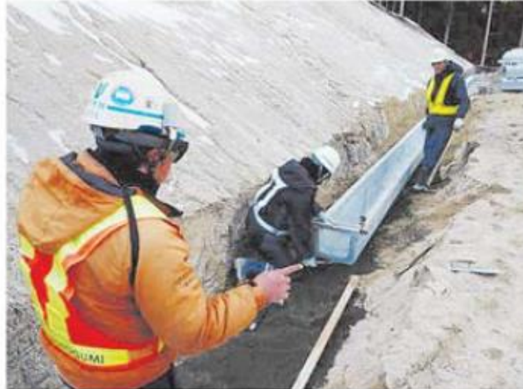
② ウェアラブル端末でのU型側溝の設置誘導
