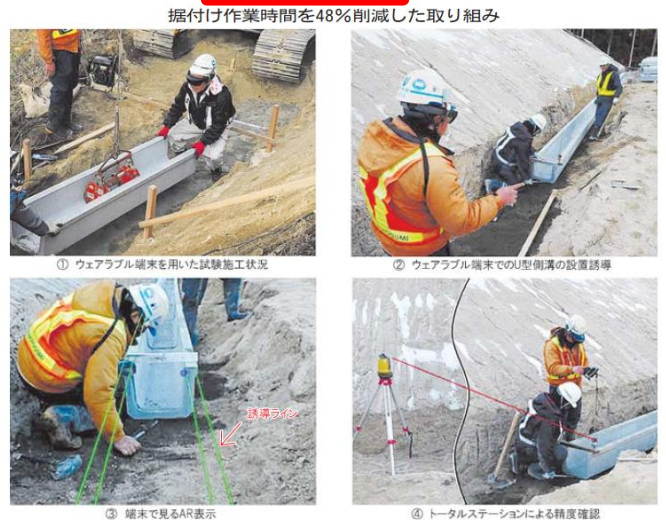
据付け作業時間を48%削減した取り組み
