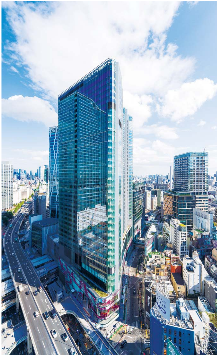
施設外観。「SHIBUYAサイド(A街区)」(手前)と「SAKURAサイド(B街区)」(道路を挟んで右側)
