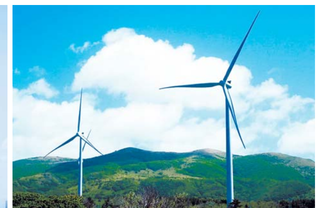
リエネ松前風力発電所。「100%再生可能エネルギー」の風が吹く!
