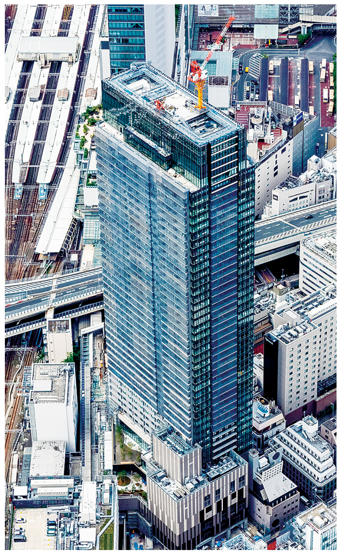
建設が進む複合再開発タワー 提供：横浜駅きた西口鶴屋地区市街地再開発組合 参加組合員 (相鉄不動産、東急)
