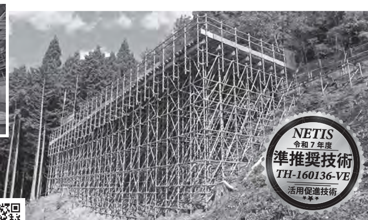
法面マルチアングル工法
