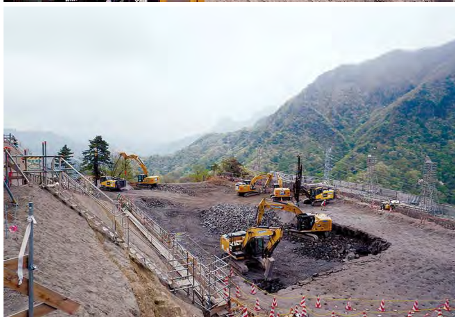
作業現場全景（4月25日撮影）
