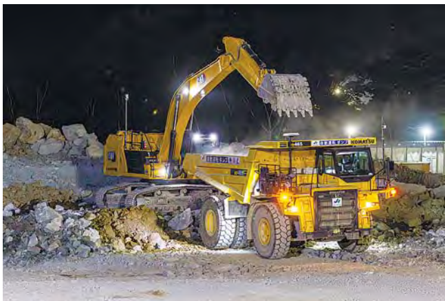
T-iROBO Rigid Dumpによる骨材運搬作業の自動化
