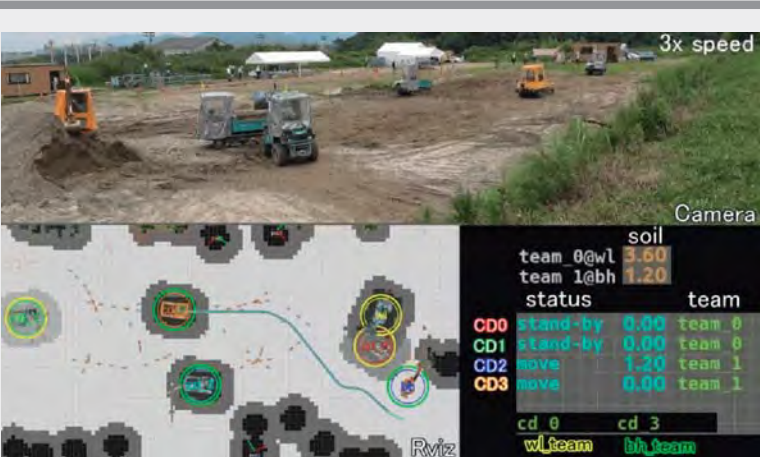
複数小型ロボットによる土工事
