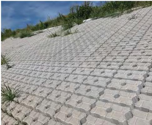
岡崎市矢作川水系乙川の河川改良で使われた低炭素コンクリートブロック。CO<sub>2</sub>削減量は年間約70ト。準になっている。今後、低炭素型コンクリートが一般化していくことを期待している。(西三河建設事務所河川港湾整備課)と力を込める。
