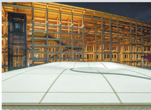
施設完成後も、データ計測という重要な仕事が残っている。屋根の内部には温度計が多数取り付けられ、膜内や膜表面の温度変化を計測し、データを蓄積。これを行うのは、「空気膜構造の良し悪しが検証されるべきだから。今回取り入れた工夫で、いまでも十分使える技術であると証明できれば延命できるかもしれない。ただし、延命させることが全てではない。検証の結果、もっと他
