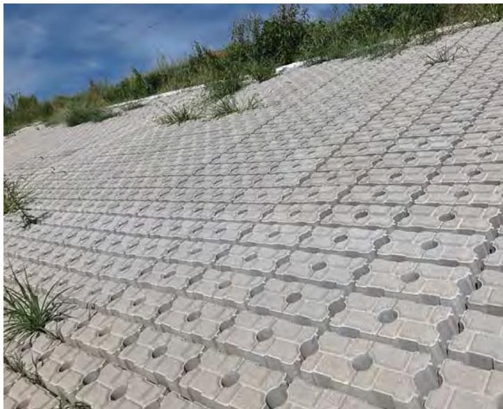
岡崎市矢作川水系乙川の河川改良で使われた低炭素コンクリートブロック。CO 2 削減量は年間約70トン。準になっている。今後、低炭素型コンクリートが一般化していくことを期待している」(西三河建設事務所河川港湾整備課)と力を込める。
