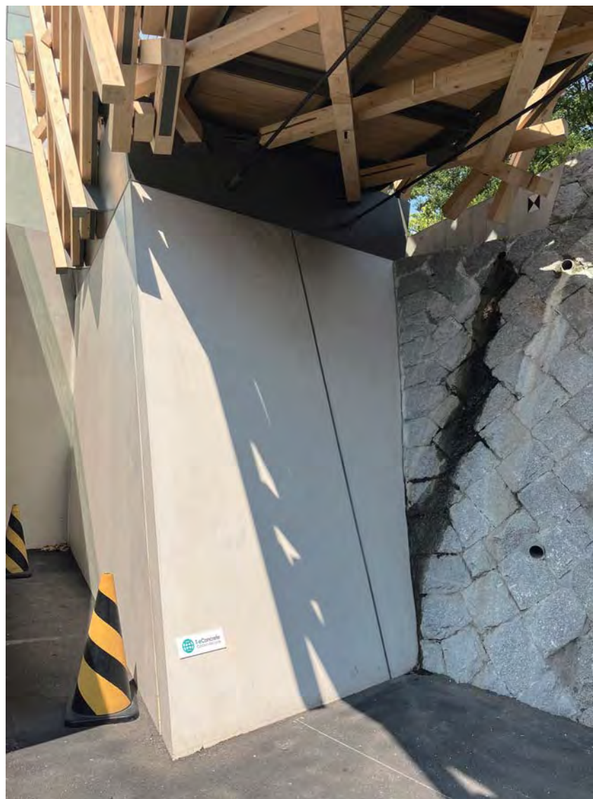
橋の基礎部のカーボンリサイクルコンクリート
