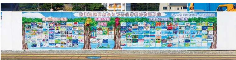
工事中の仮囲いには地元小学生の絵画を展示
